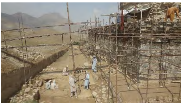
تصویر 35: نمای جریان ترمیم ساختمان نوسانی یا Drum پائینی تصویر 36: جریان حفریات و ترمیم بخش‌های سمت جنوب ستوپه
