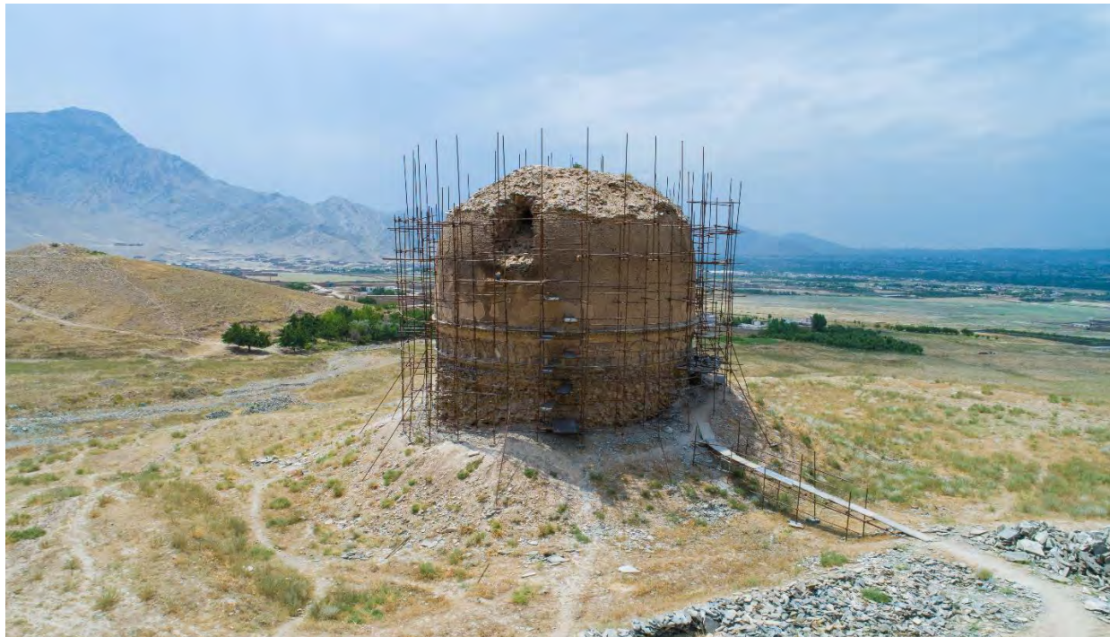
تصویر 9: نمای جناح شمالی ستوپه در جریان استحکام بندی و مرمت گنبد.
