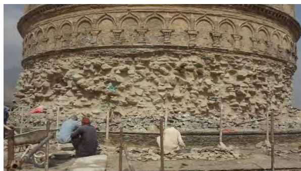
تصویر 35: نمای جریان ترمیم ساختمان نوسانی یا Drum پائینی تصویر 36: جریان حفریات و ترمیم بخش‌های سمت جنوب ستوپه
