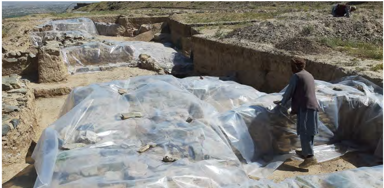
تصویر 84: نمای جریان پوشش دیوارها و ساختمان‌های باستانی ساحة (002) با پلاستیک جهت حفاظت و پر کاری یا Backfilling.
